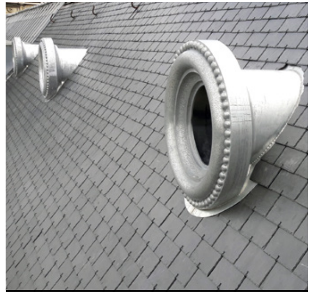
GARE D'AUSTERLITZ - PARIS (75) Couverture ardoise et ornements en zinc
