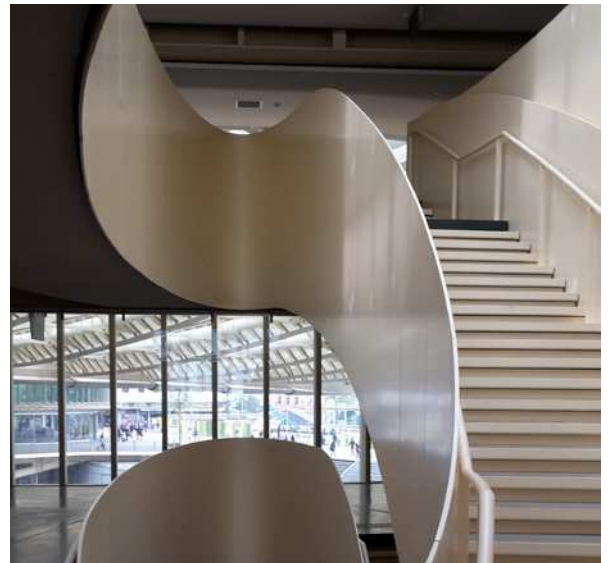
LES HALLES - PARIS (75) Main courante et habillages métalliques hélicoïdaux
